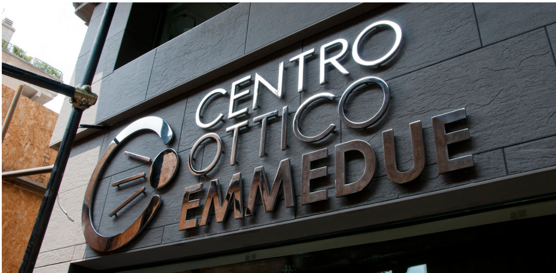
Nella foto superiore lo smontaggio del cantiere esterno che rivela il nuovo rivestimento e la nuova insegna in acciaio (foto inferiore).
