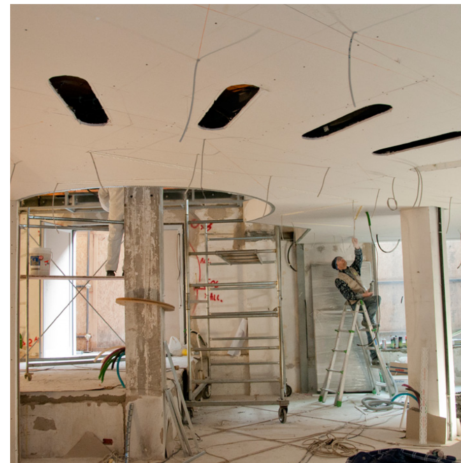
Lavorazione del soffitto per il sistema d'illuminazione.
